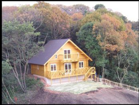
屋外在宅復帰訓練室
